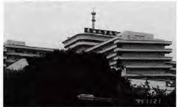
photo-6 そびえ立つ東海大学病院
