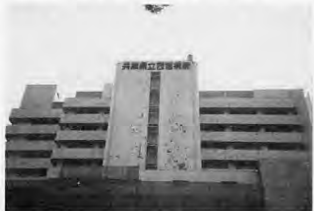
震災後の県立西宮病院
